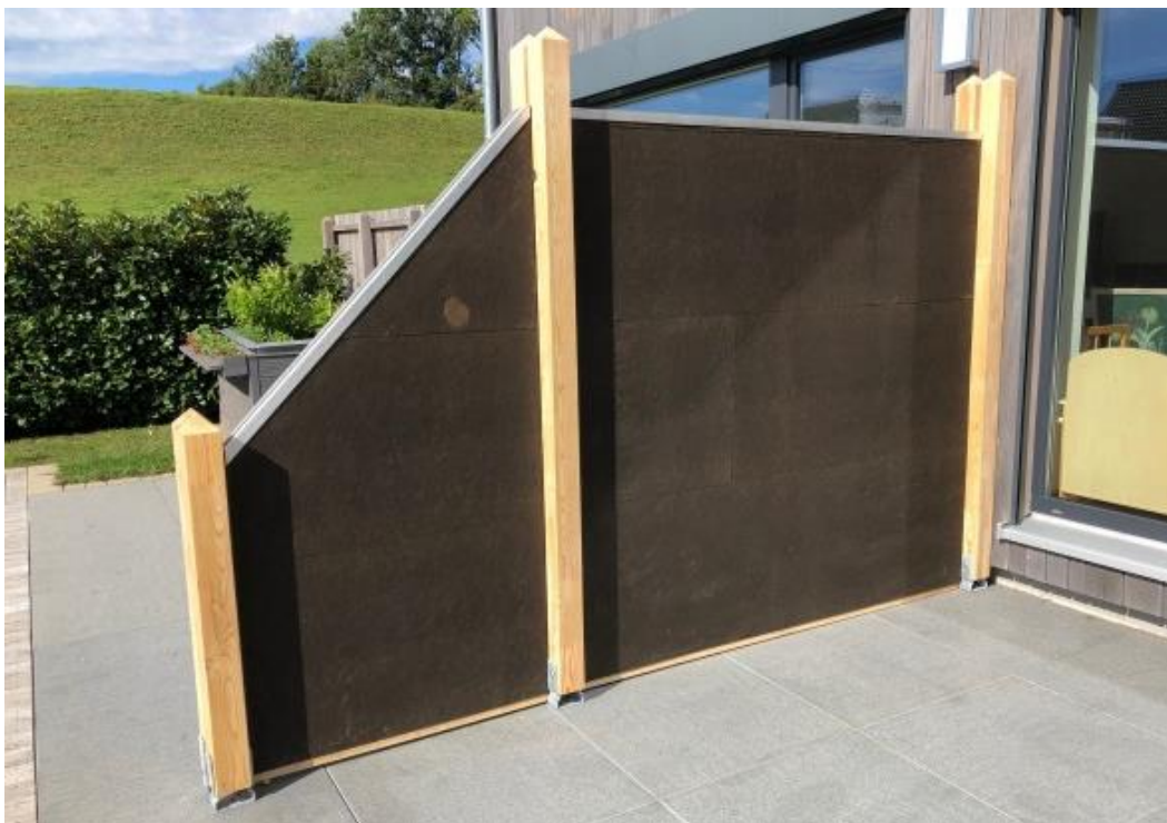
Abbildung 3: Schallschutzwand vor dem Anbringen der Holzverkleidung
